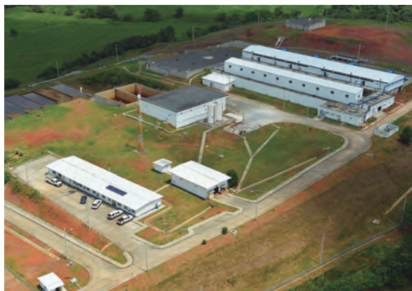
Figura 6. Planta de agua potable de Mendoza. Foto CIAC - ACP, 2013.
