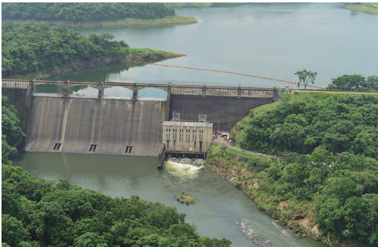
Figura 8. Planta eléctrica Madden - Embalse de Alhajuela. Foto EAC - ACP, 2013.
