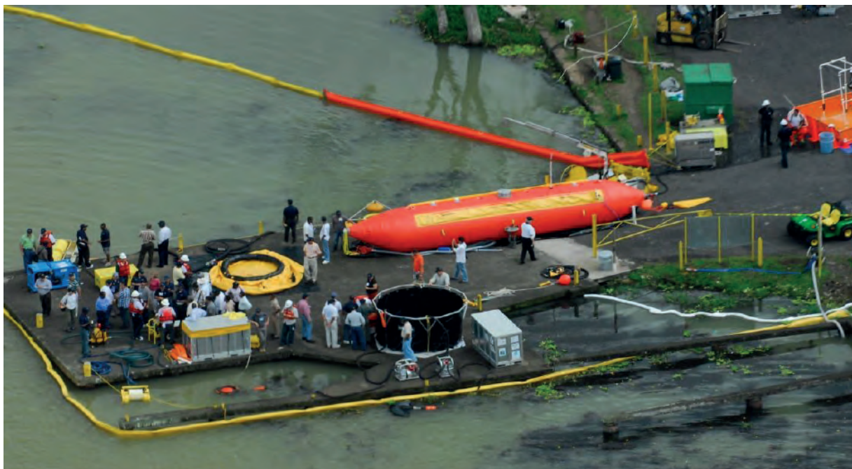
Figura 26. Ejercicio a gran escala de despliegue de equipo de recolección de derrames en el área de Gamboa. Foto: ACP, 2012.
