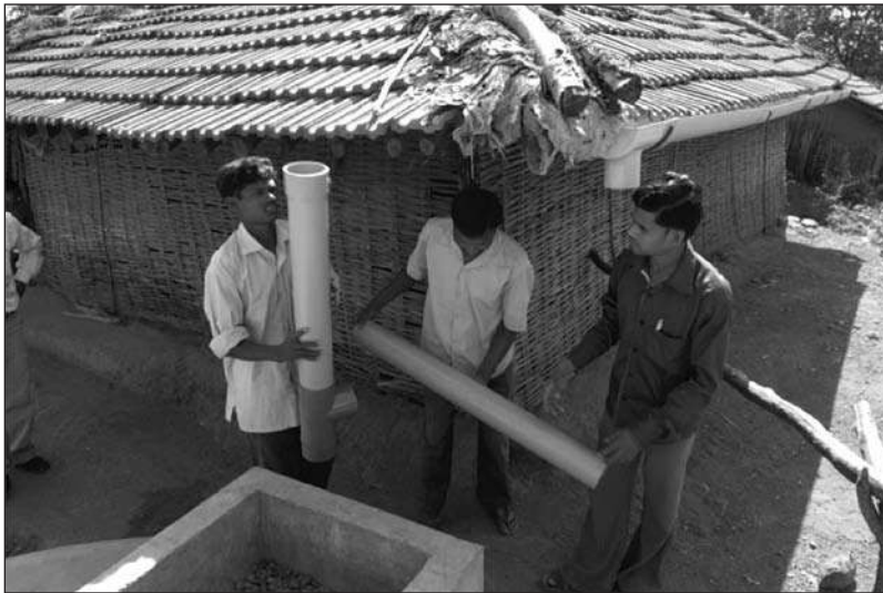
Fig. 3 Participación de trabajadores locales en la construcción
