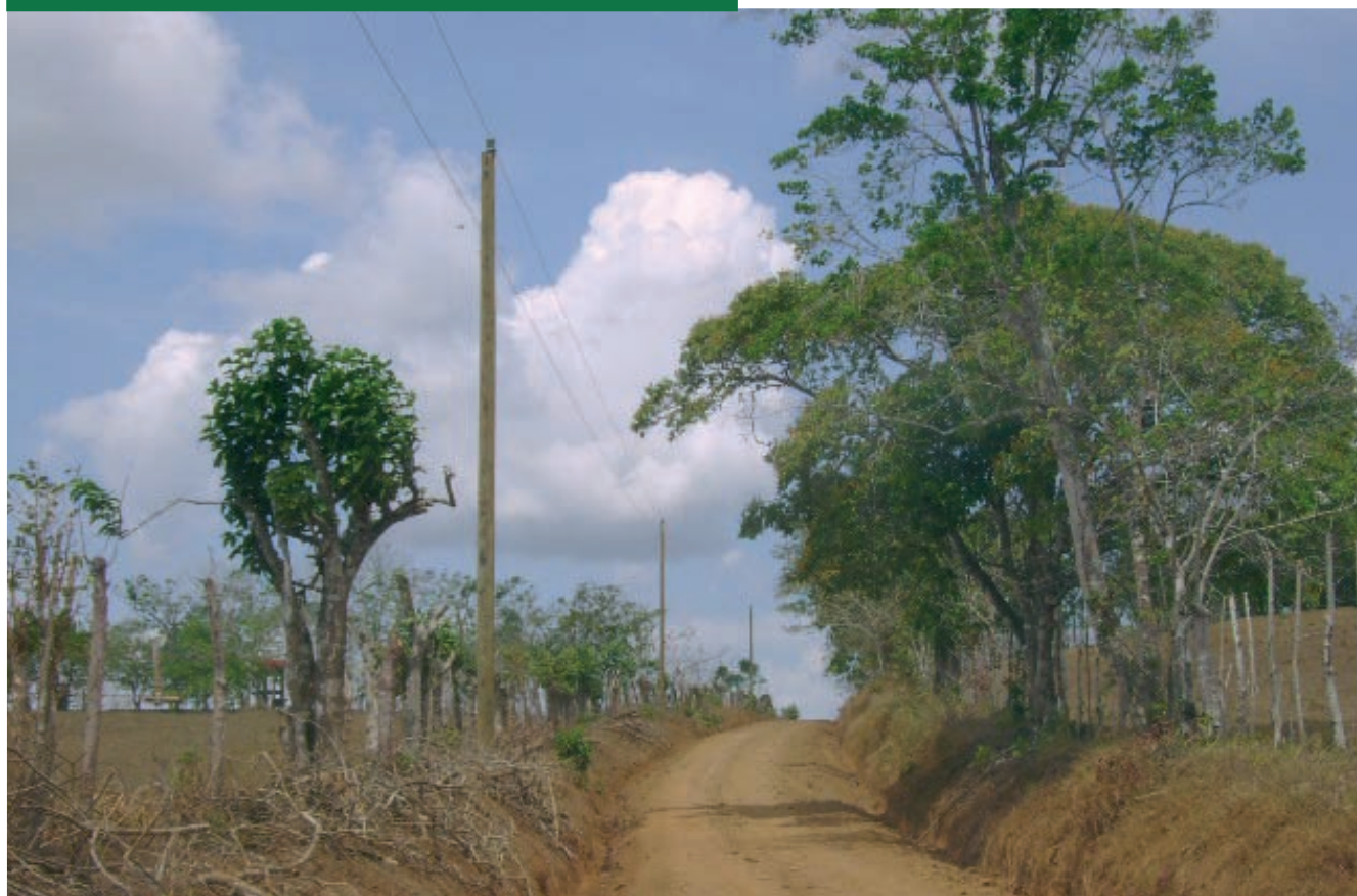
Alto del Jobo, electrificación
