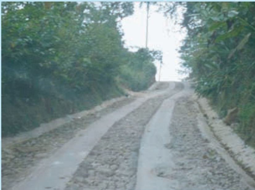
Carretera, Chiguirí Arriba - El Valle
