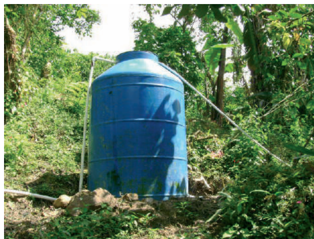
Río Indio, tanque de almacenamiento
