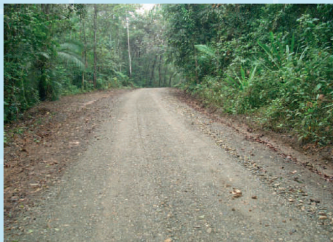
Camino del Oleoducto
